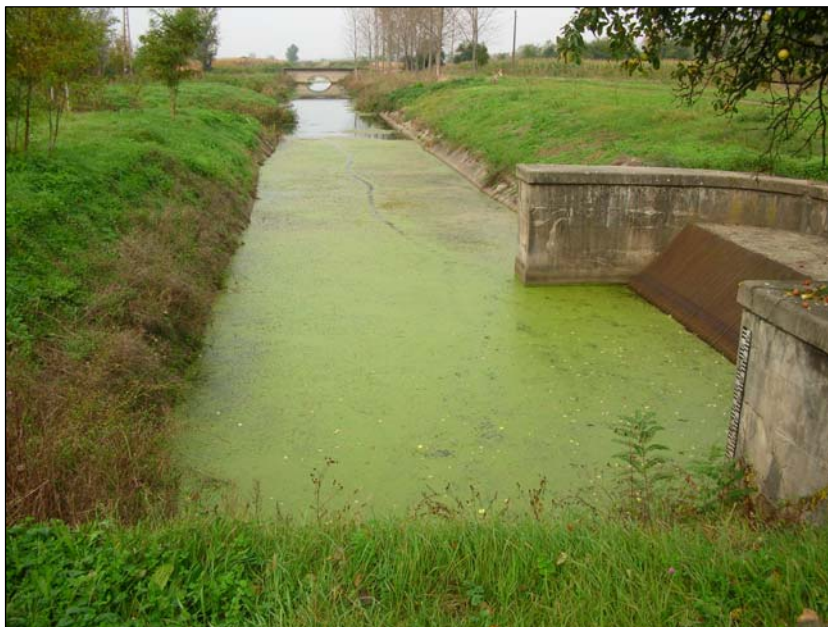
Slika 4: Drenažni kanal uz CS Vrba (lokalitet Kovin – Dubovac)
